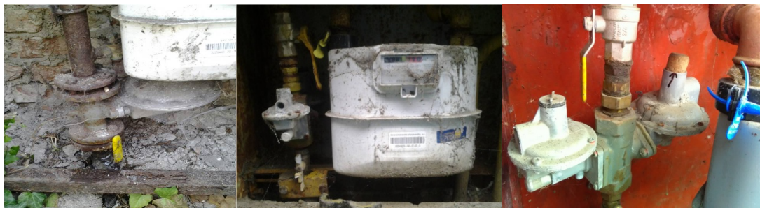
Kresba 18: Příklady špatné péče o regulátory v provozu
