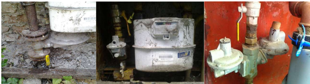
Obrázek 18: Příklady špatné péče o regulátory v provozu
