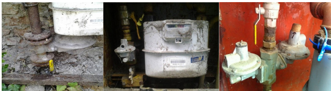
Obrázek 18: Příklady špatné péče o regulátory v provozu
